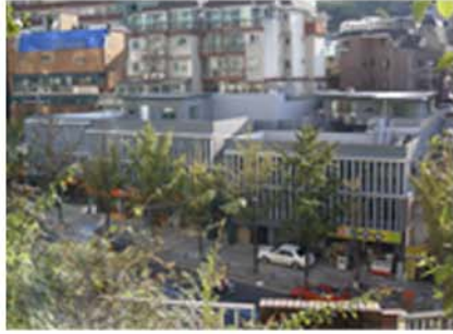
홍제동 리노베이션 Hongjedong Renovation
