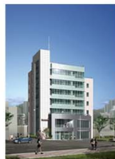
방화동 업무시설 및 근린생활시설 Banghwa-dong Complex Building
