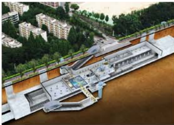
서울시 지하철9호선 3단계 922공구
